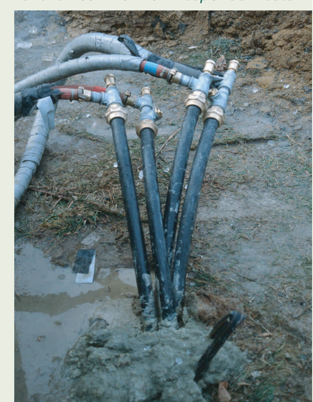
Erdwärmesonde (Doppel-U-Rohr) während eines Thermal-Response-Tests
